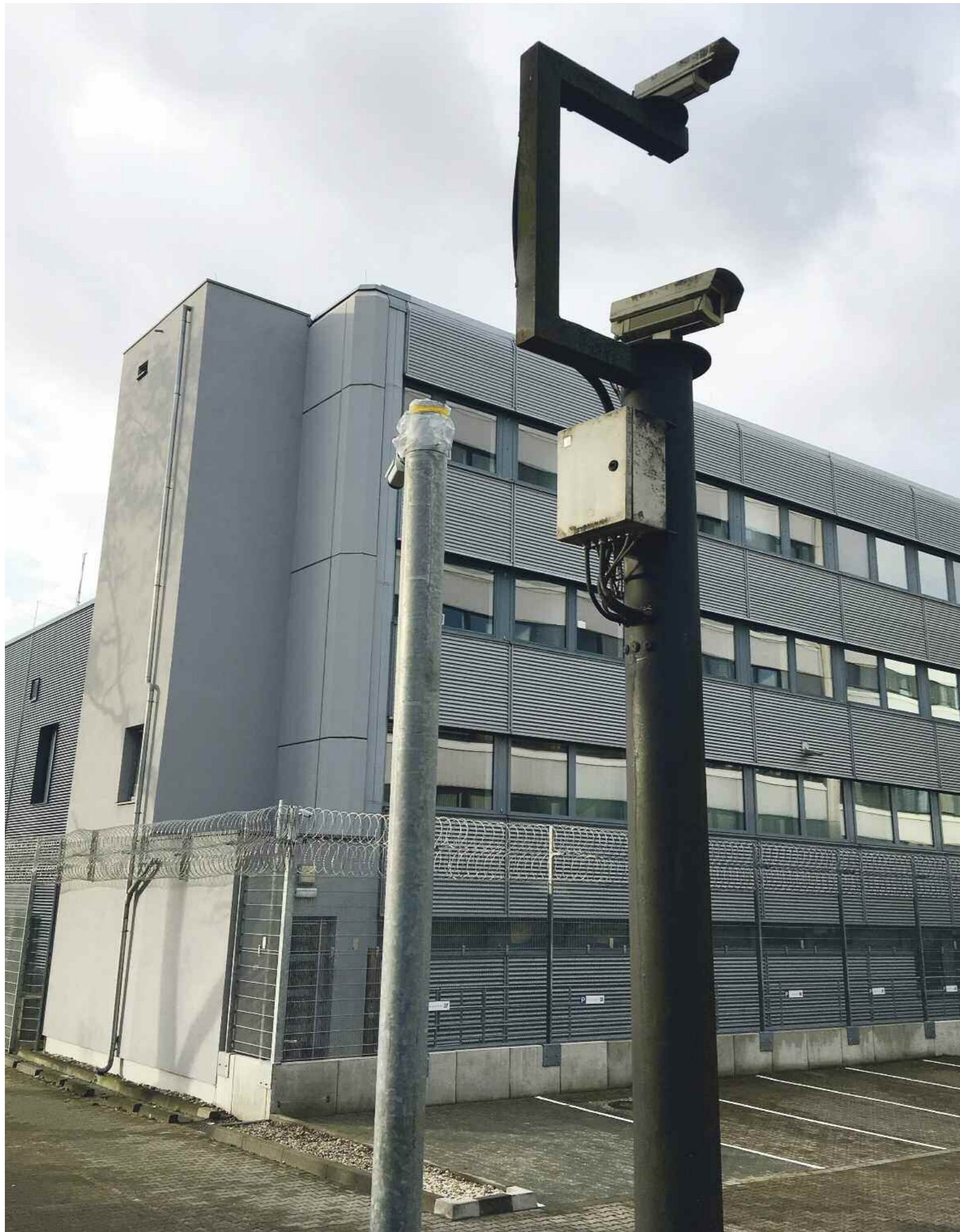
Das e-shelter-Datencenter in Berlin-Spandau ist in einer alten Industrieanlage auf insgesamt 13.000 m 2 untergebracht. Die umfangreichen Überwachungs- und Sicherheitsmaßnahmen rund um das Gelände sind entscheidend für die Datensicherheit der Berliner*innen. Eine Betriebsstörung des Centers könnte außerdem die Internetversorgung der Region Berlin beeinträchtigen. Das e-shelter ist Teil des Berliner Internet-Knotens, einem Verein zur Förderung und Verbesserung des regionalen Internet-Datenaustauschs im Raum Berlin-Brandenburg.
